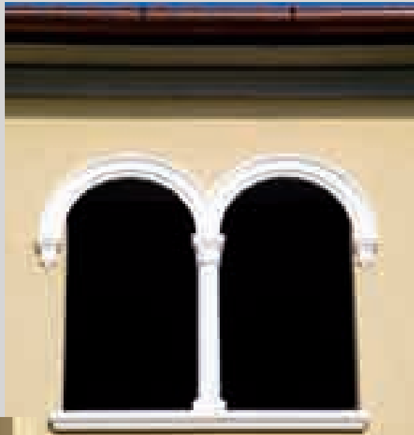
Balcon, corniches et éléments architectoniques
